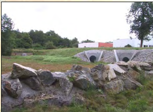
Ouvrage hydraulique - Cliché Calligée
