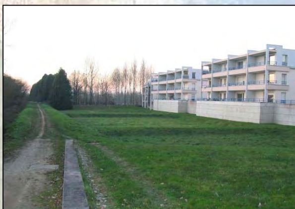
Bassins de rétention - Cliché Calligée
